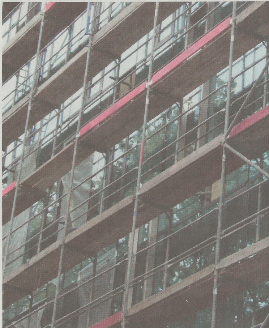
Das Gebäude steht, das Gerüst kann abgebaut werden. Wer erst jetzt an den Gebäudebetrieb den
